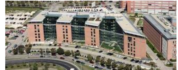
Ungarn „D“ Building IVG, Budapest
