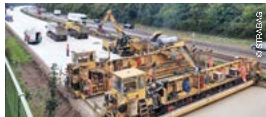
Ausbau der Autobahn A1
