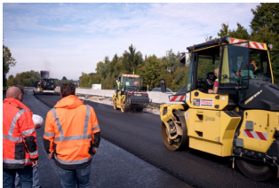
STRABAG testet vollautonomen Asphalteinbau und smarte Absperr-Pylonen © STRABAG
