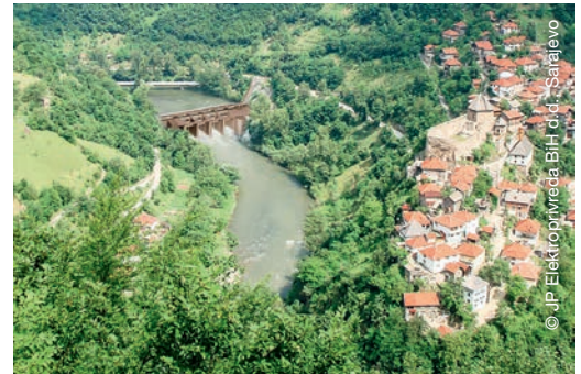
Wasserkraftwerk am Fluss Bosna
