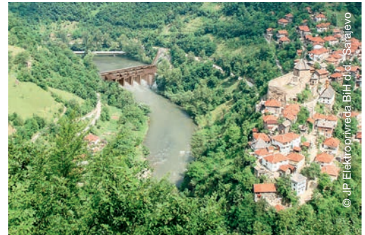
Wasserkraftwerk am Fluss Bosna
