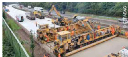
Ausbau der Autobahn A 1
