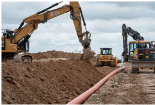
Tiefbauarbeiten an der Stromkabeltrasse SuedOstLink in Thüringen © STRABAG AG
