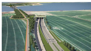
Lückenschluss im Skandinavien-Mittelmeer-Korridor © DB Netz/Ramboll
