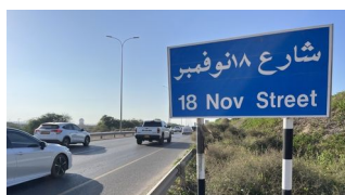
Umfangreicher Ausbau der Straßen 18th of November und Al Mouj in Maskat © STRABAG
