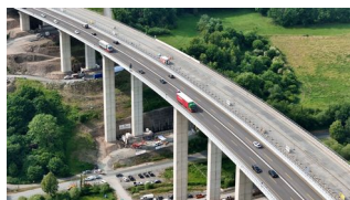
Innovativer Querverschub an neu gebauter Autobahnbrücke © Autobahn Westfalen
