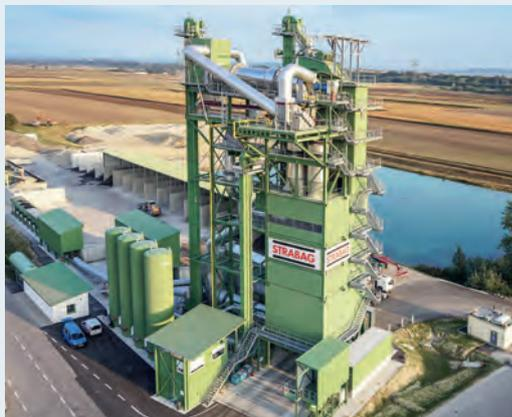
Die Asphaltmischanlage verarbeitet bis zu 50 % Recyclingmaterial.
